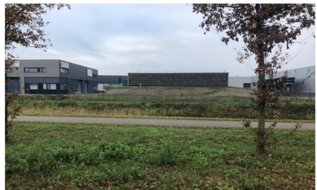
Foto schakelstation op De Laarberg
